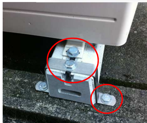
施工例1、1階コンクリート土間施工 (雌ねじアンカー施工)
