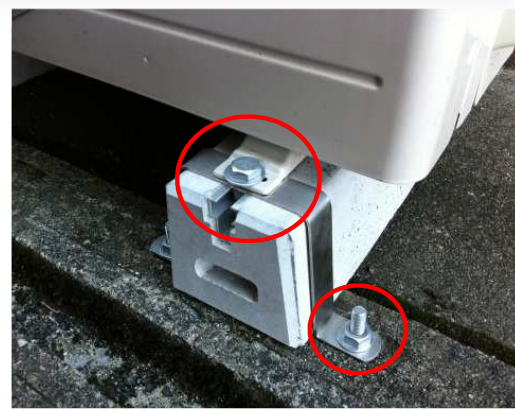
施工例2、屋上などの高耐震施工 (雄ねじアンカー又はケミカルアンカー施工)
